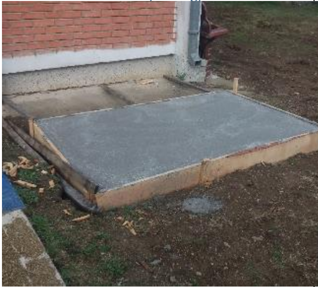
Bazamentet e vendosjes së gjeneratorëve
