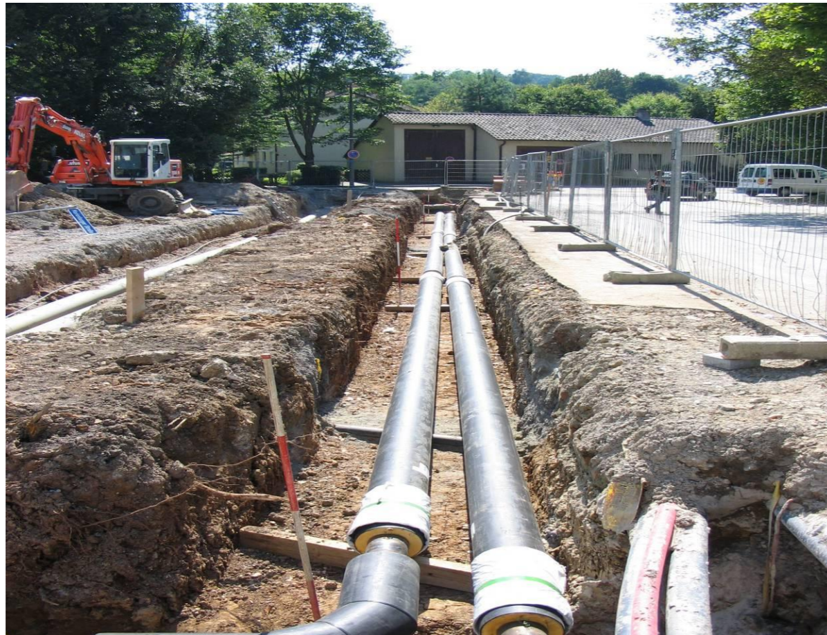
fig. 44. Pozita e tubacioneve në kanal
