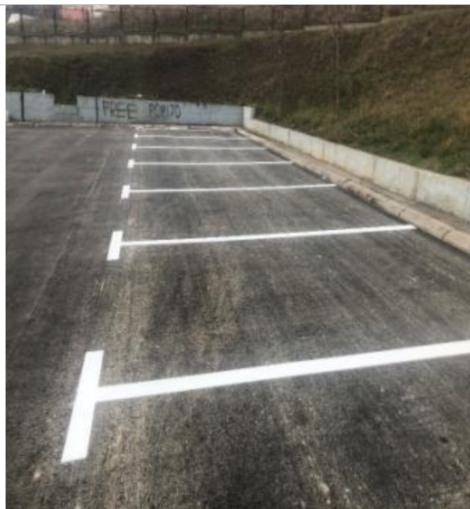
Asfaltimi i parkingut tek QMF në lagjen “Bregu i Diellit”
