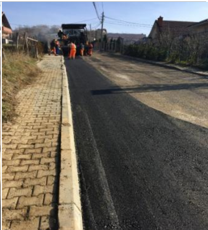
SANIMI I KANALIT NË RRUGËN “QËNDRESA”, MAT
