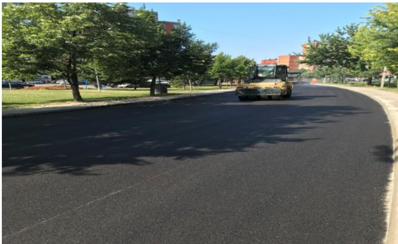
Asfaltimi i rrugës "Ilaz Kodra"
