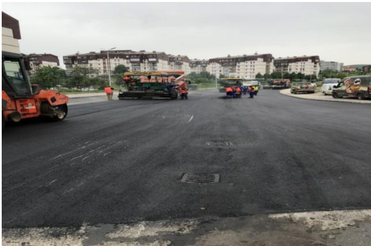
RIASFALTIMI I RRUGËS "XHELADIN HANA"
