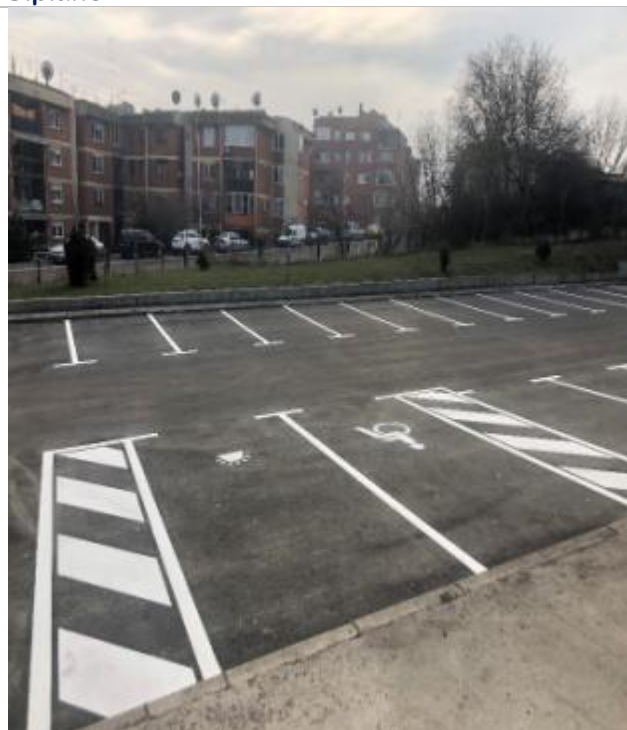
Asfaltimi i parkingut tek QMF në lagjen “Bregu i Diellit”
