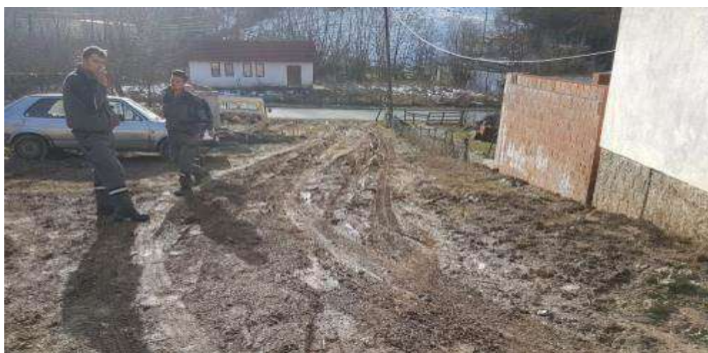
Trajtimi i rrugës me kubza betoni (Grashticë)
